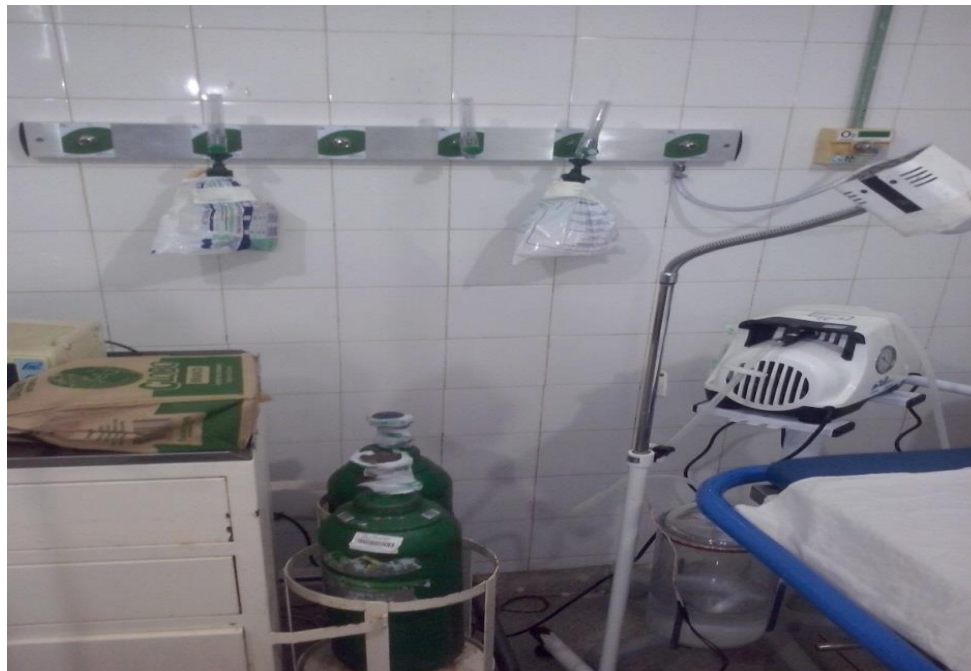
Foto: Instalação de régua de distribuição de oxigênio nova.
